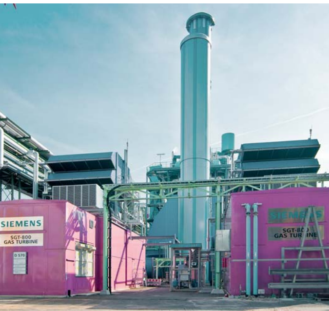
Gas turbine plant, Infraserp Höchst
