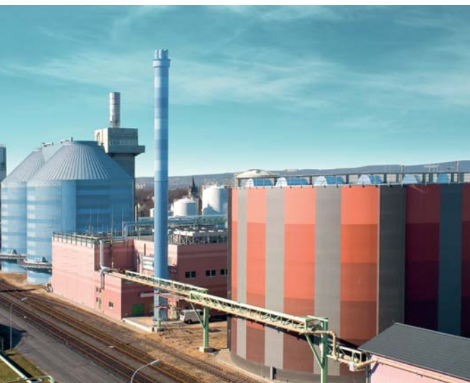
Biogas plant, Infraser serv Höchst
