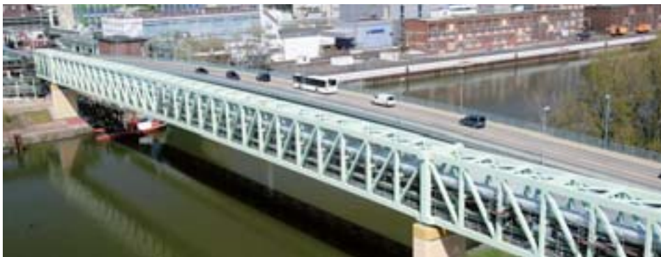
2009 wurde eine neue Brücke im Industriepark geschlagen: Eine Versorgungsbrücke für verschiedene Medien wurde unmittelbar neben der mittleren Mainbrücke errichtet.
