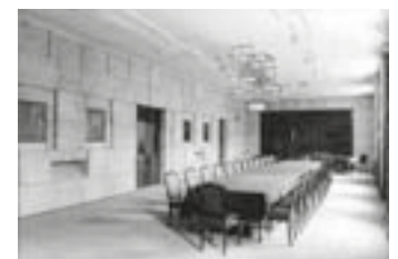
Der ganz mit Travertin verkleidete „Marmorsaal“ in seinem ursprünglichen Zustand.
