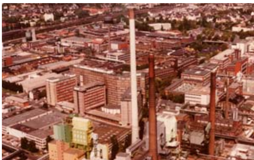
Der im Jahr 1982 errichtete Kamin war ursprünglich weiß gestrichen. Auf diesem Luftbild aus dem Jahr 1990 ist rechts hinter dem Kamin der Peter-Behrens-Bau zu sehen, links davon steht noch wie ein Riegel das Verkaufshochhaus C 660 – das Gebäude aus den 1950er Jahren wurde im Jahr 2003 abgerissen.
