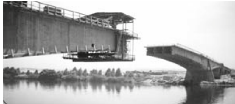
Die Mittelbrücke im Bau.
