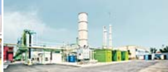
Bioerdgas-Aufbereitungsanlage von Infranova.
