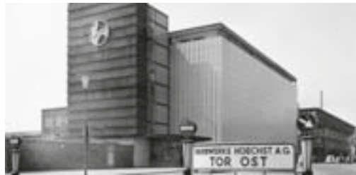
Zunächst trägt das neue Pharma-Verpackungsgebäude eine Fassadenverkleidung aus dem Kunststoff Hostalit.
