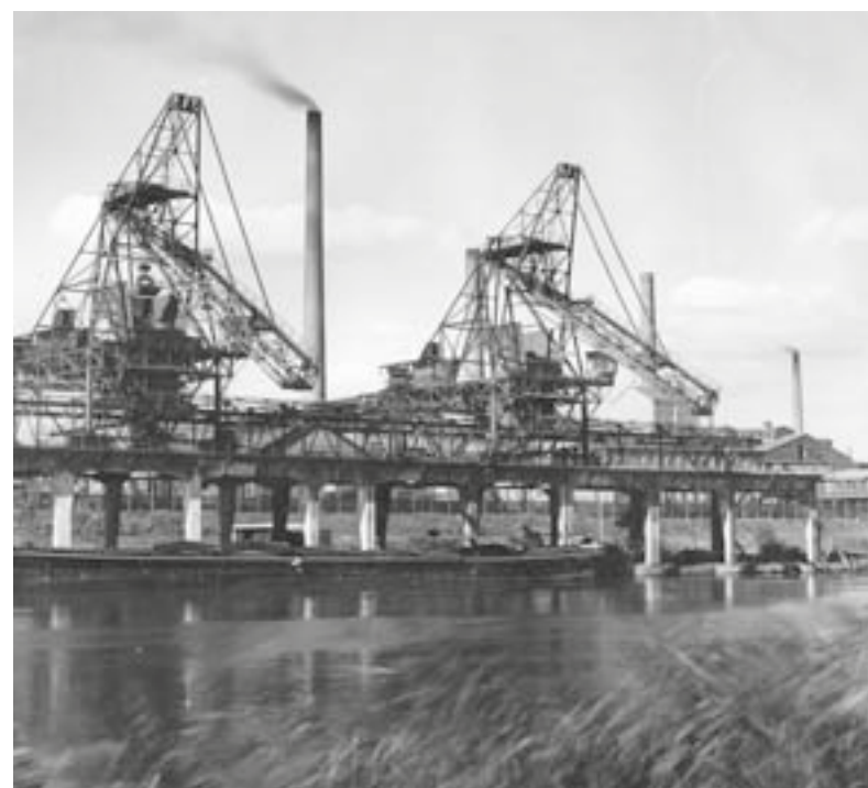
Die Kohlentransportanlage („Kotra“) hatte bis 1966 die von Schiffen angelieferte Kohle über Transportbänder am gesamten Standort verteilt
