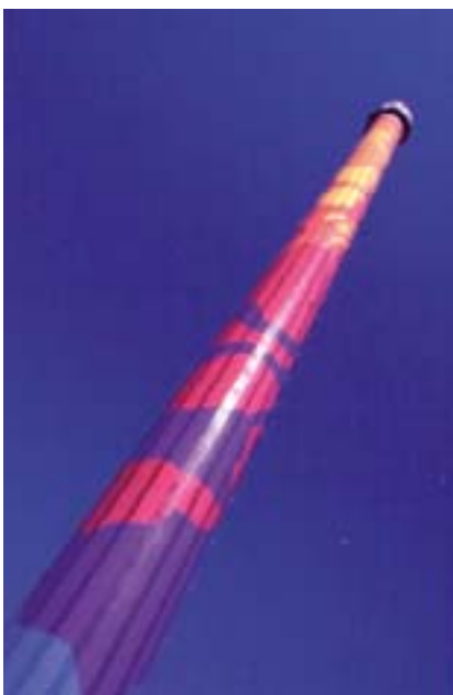
Der 167 Meter hoch aufragende Kamin war ursprünglich weiß gestrichen. Seit 1998 erstrahlt er in kräftigen Farben.
