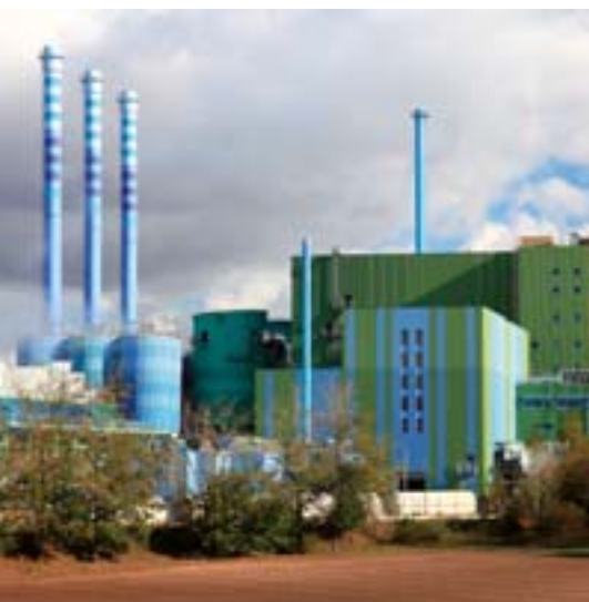
Eine Ersatzbrennstoff-Anlage, im Süden des Industrieparks gelegen, sorgt für nachhaltige Energieerzeugung.
