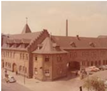
1920 zog die Werkfeuerwehr in das ursprünglich als zentrales Fuhrwesen im Jahr 1891 erbaute Gebäude an Tor Ost. Diese Feuerwache wurde 1960/61 abgerissen und das Empfangsgebäude C 820 entstand dort. Die Feuerwehr nahm das neue Gebäude C 299 in Betrieb. Die zweite Feuerwache auf der südlichen Mainseite wurde im Jahr 1977 bezogen.
